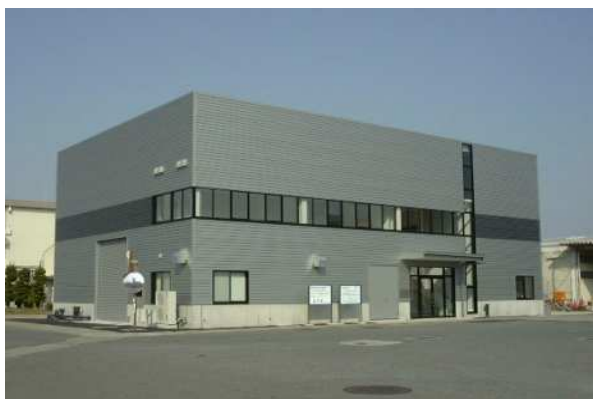
図 1. 大阪市水道局膜ろ過試験フィールド (最適先端処理技術実験施設)
