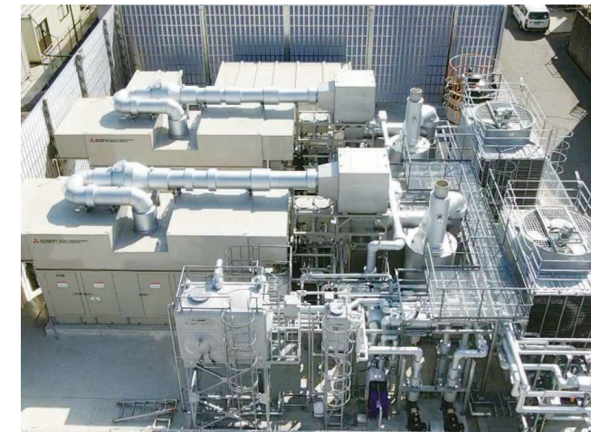
出力合計2,000kWのコージェネレーション設備
