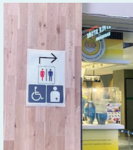
ビッグビジョンコートに設置された廃棄木材利用パネル
