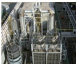
ガスエンジン発電機で電力を得るとともに、排熱を蒸気として回収して有効利用するシステムです。本社工場、多木建材の合計使用電力の約40%をまかなっており節電対策にも有効な手段となっています。
