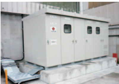
2010年 高効率変圧器導入
